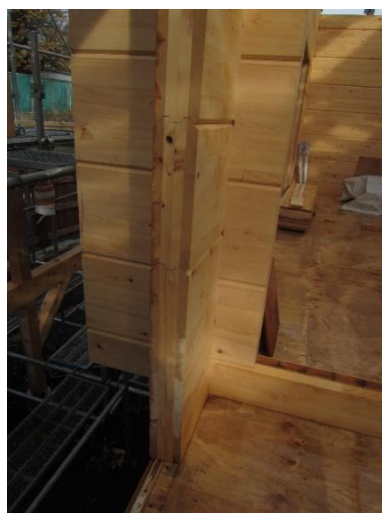
X2×Y2 通 CLT ログ ヒノキ Mx90-3-4 (厚さ 120 mm、高さ 400 mm)
