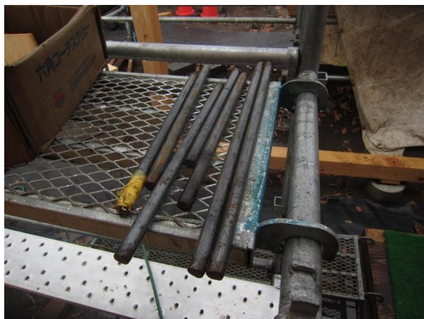
CLT ログを連結する鋼製ダボ
