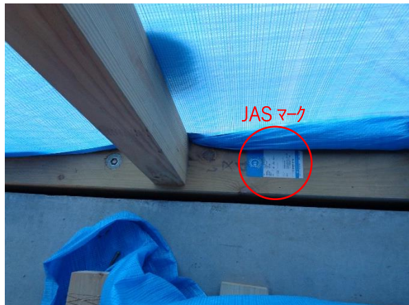
X6×Y1-5通 土台 D1：JAS構造用集成材（中断面）ベイマツに変更
