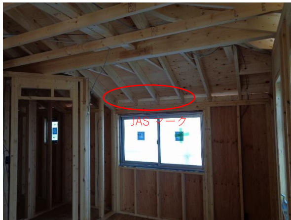
X13~18×Y12~14 通 2階 縦枠・上下枠・天井根太・垂木： JAS 枠組壁工法構造用製材
