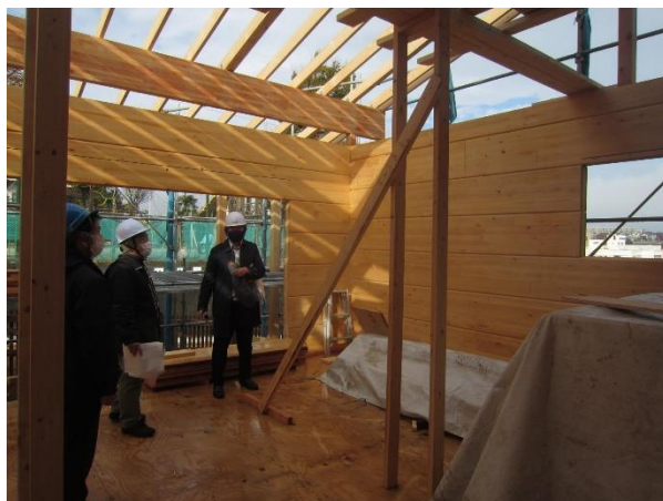
X2×Y4~5 通 CLT ログ ヒノキ Mx90-3-4 (厚さ 120 mm、高さ 400 mm)
