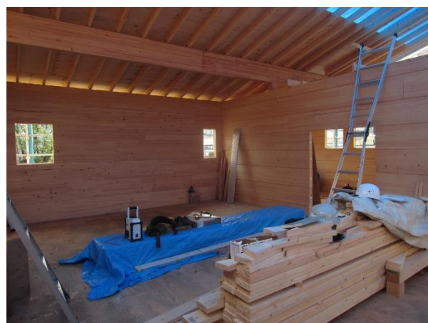
X2~3×Y2~3 通 CLT ログ ヒノキ Mx90-3-4 (厚さ 120 mm、高さ 400 mm)
