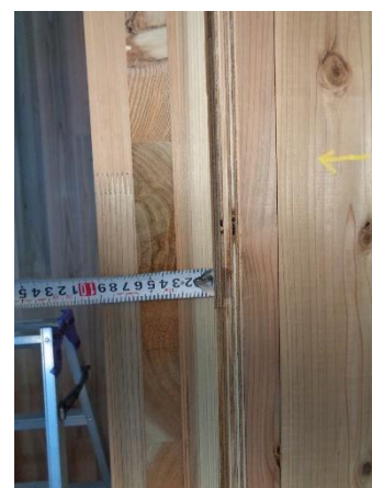
X4×Y4~3 通 壁 No.1 : CLT 3層3プライ 杉
