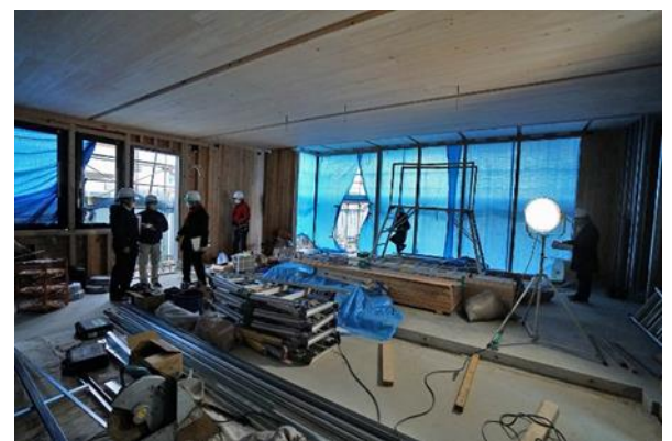
内観 事務室よりロビー、エントランスを見る
