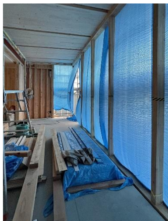
X6×Y4-6通 土台、梁：機械等級製材からJAS構造用集成材（中断面）に変更
