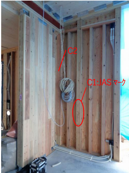
X5×Y5~6 通 壁 8 : CLT 5層 5プライ 杉 X5×Y6 通 柱 C2 : JAS 集成材 (中) ~変更
