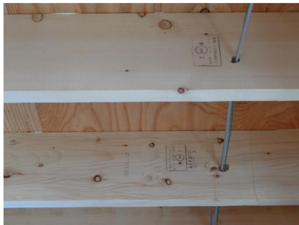
X15~18×Y12~13 通 2階床根太 210 JAS 枠組壁工法構造用製材 SPF
