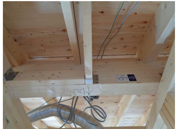
X0~18×Y12~13 2階 小屋梁： JAS 構造用集成材 410（中断面）スプルース
