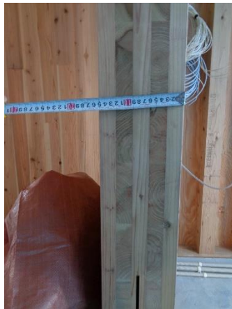
X5×Y5~6 通 壁 No.8 : CLT 5層 5プライ 杉
