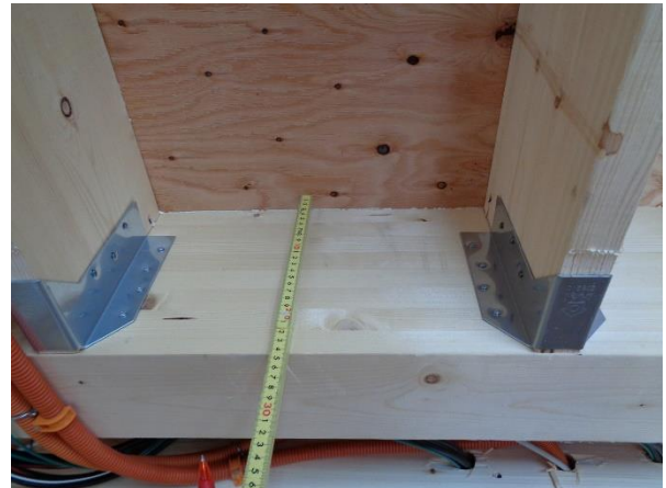
X0~5×Y7 通 2階床梁： JAS 構造用 集成材 610 (中断面) スプルース
