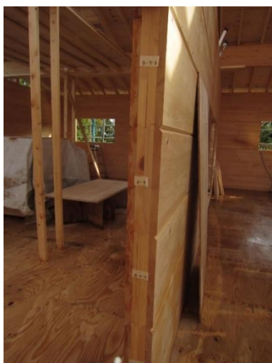
X2~3×Y2 通 CLT ログ ヒノキ Mx90-3-4 (厚さ 120 mm、高さ 400 mm)
