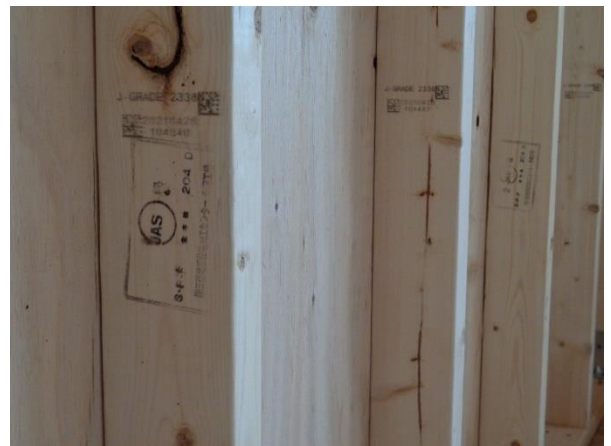
X8~9×Y5~8 通 1階 縦枠 204 JAS 枠組壁工法構造用製材 SPF
