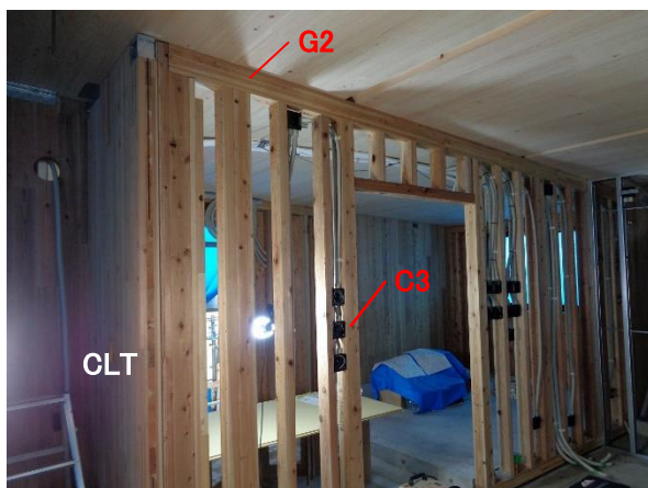
X4~2×Y4~3 通 梁 G2 : LVL→JAS 構造用集 成材(中断面)、柱 C3 : JAS 機械等級製材
