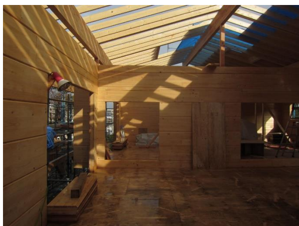
X2~3×Y4 通 CLT ログ ヒノキ Mx90-3-4 (厚さ 120 mm、高さ 400 mm)
