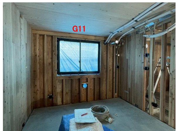
X1×Y1~4 通 梁 G11、土台 D1： 機械等級 → JAS 構造用集成材（中断面）に変更
