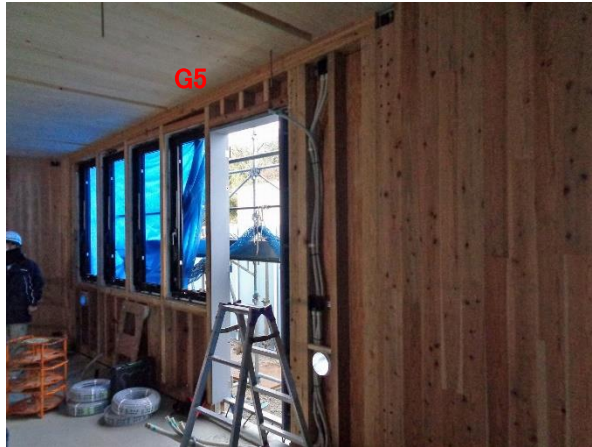
X5~2×Y6 通 梁 G5、土台 D1： 機械等級 → JAS 構造用集成材（中断面）に変更
