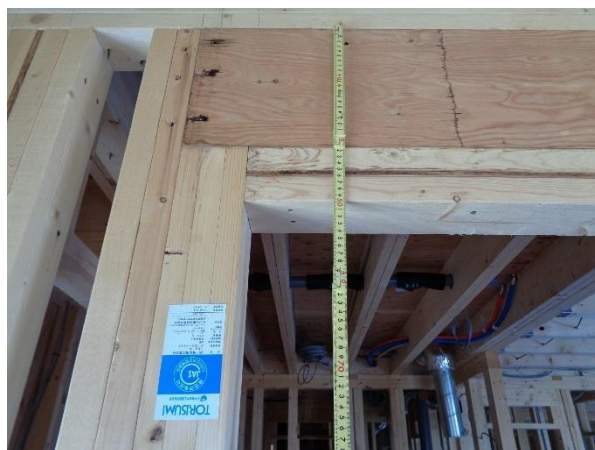
X12~15×Y3 通 梁: JAS 構造用 LVL(140E) 410、柱: JAS 構造用集成材 (小断面)
