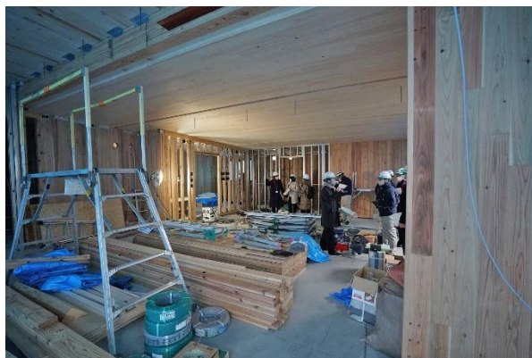
内観 エントランスよりロビー、事務室を見る
