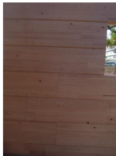
運搬と施工上の都合により、CLT ログは短くカ ット。写真はたて継ぎ部分
