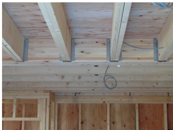
X12~15×Y3 通 梁: JAS 構造用 LVL(140E) 410、柱: JAS 構造用集成材 (小断面)
