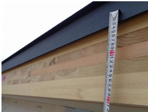
破風あらわし (Y1 通り側) 屋根： CLT 5層7プライ 杉+桧
