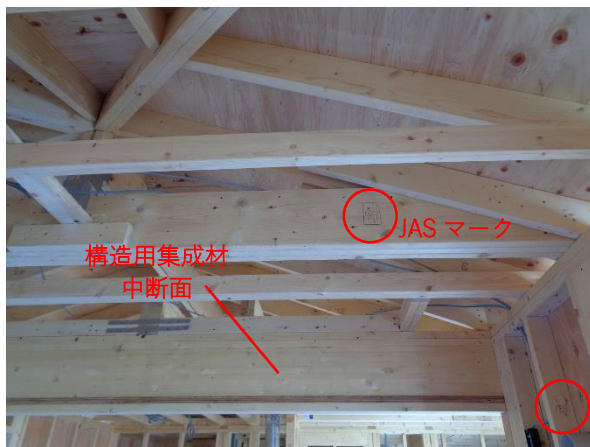
X2~5×Y4~6 通 2階 天井根太・垂木・縦枠：
