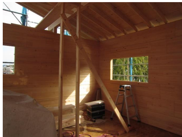
X3×Y4~5 通 CLT ログ ヒノキ Mx90-3-4 (厚さ 120 mm、高さ 400 mm)
