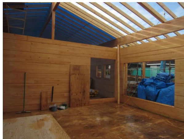
X2×Y3~4 通 CLT ログ ヒノキ Mx90-3-4 (厚さ 120 mm、高さ 400 mm)
