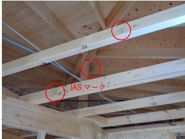
X5~7×Y6~9 2階 上桢・天井根太・垂木： JAS 桢組壁工法構造用製材 SPF
