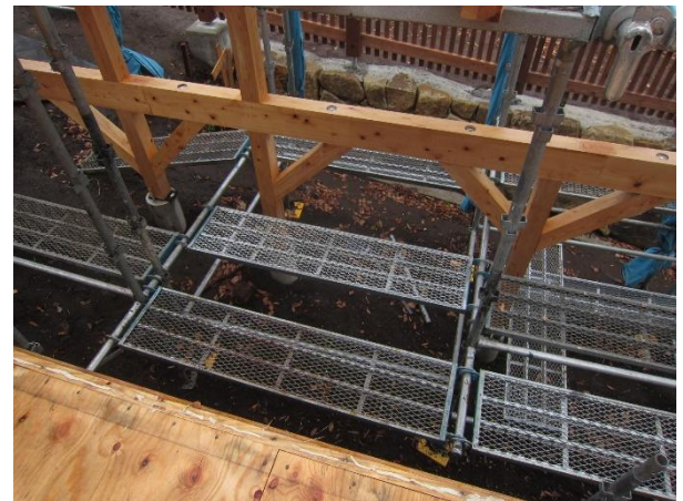
床下 方杖で補強された独立基礎
