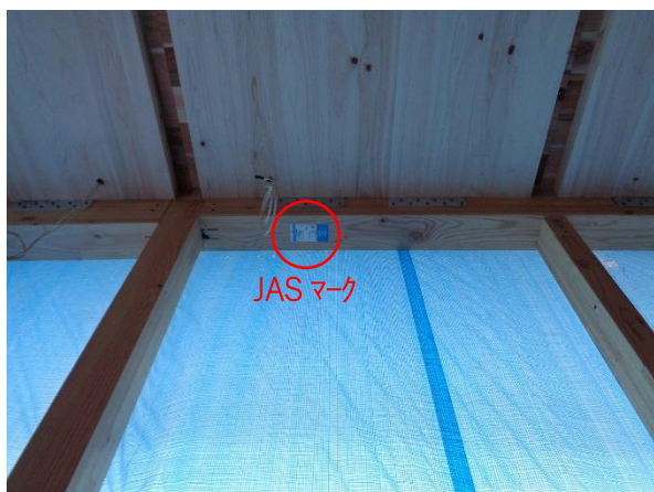
X6×Y4-5通 桁 G12：JAS構造用集成材（中断面）ベイマツに変更
