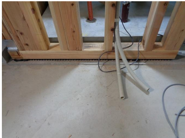
X4~3×Y4~3 通 土台 D2、3：機械等級 →集成材（小断面）に変更で助成対象外
