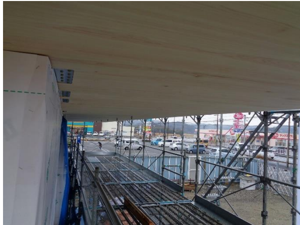
X6×Y1~6 軒天井あらわし 屋根： CLT 5層7プライ 杉+桧 せん断金物
