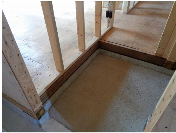
X7~8×Y9~10 通 1階 土台：JAS 目視等級 構造用製材 ベイツガ（対象外）
