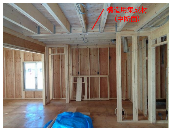
X11~15×Y2~7 通 1階 縦枠・上下枠・根太 JAS 枠組壁工法構造用製材、梁:構造用 LVL
