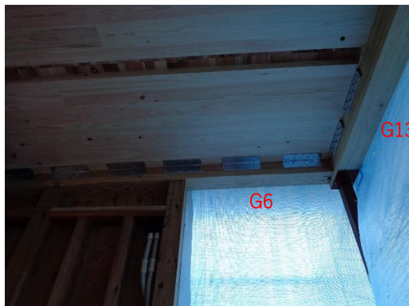
X6×Y5-6通 桁 G13：JAS集成材（中） X5-6×Y6通 桁 G6：機械等級製材→
