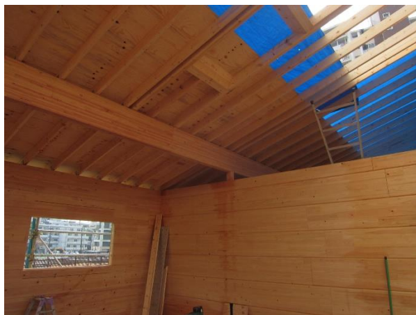
X3×Y3~4 通 CLT ログ ヒノキ 集成材は助成対象外
