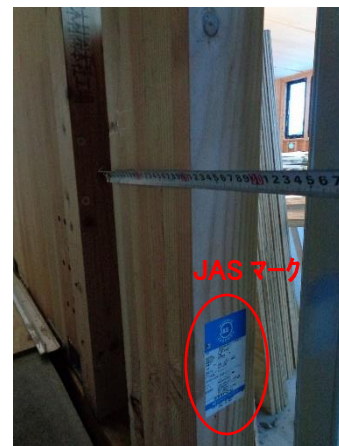
X5×Y3 通 柱 C4 : JAS 構造用集成材 (中断面) ベイマツに変更
