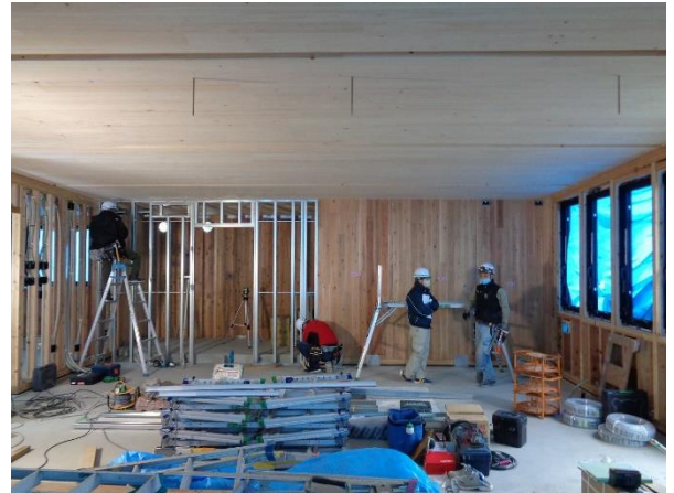
X5~2×Y4~6 通 屋根：CLT 5層7プライ 杉+桧
