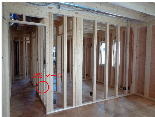
X14~18×Y6~10 通 1階 縦枠・上下枠・
