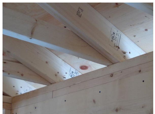
X0~1×Y10~12 2階 上桢・垂木： JAS 桢組壁工法構造用製材 206 SPF
