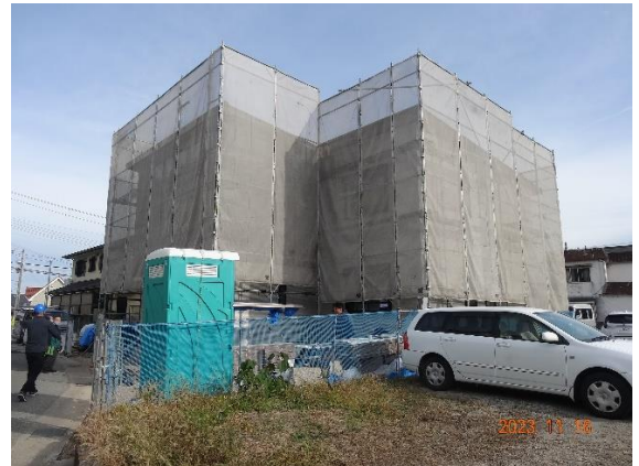
外観 2階建 長屋 前面道路 西側より
