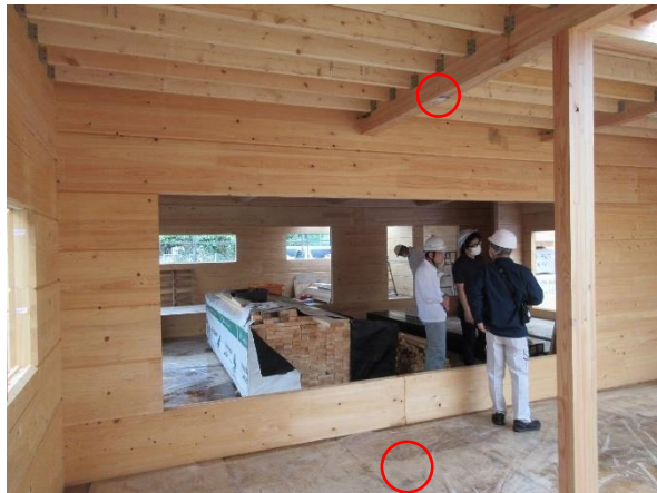
1 階 X2~4×Y6~7 通 壁: JAS 構造材 CLT t120 桧、梁: JAS 構造用集成材 米松 床: JAS 構造用合板
