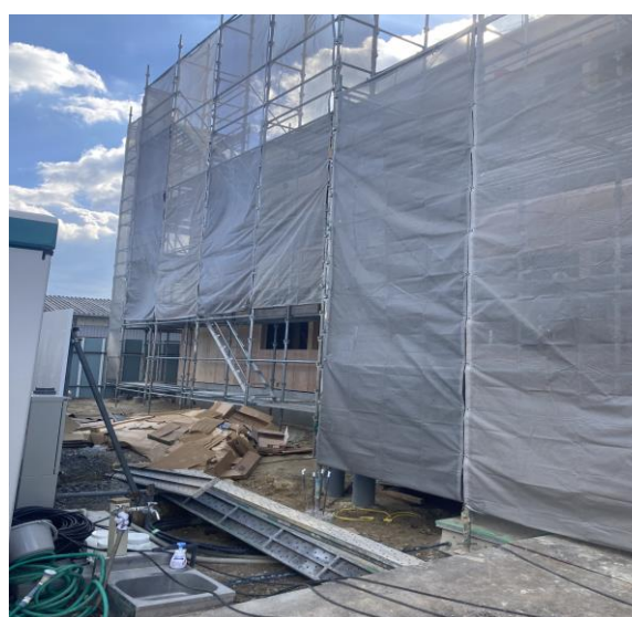
建物外観（西側より撮影）
