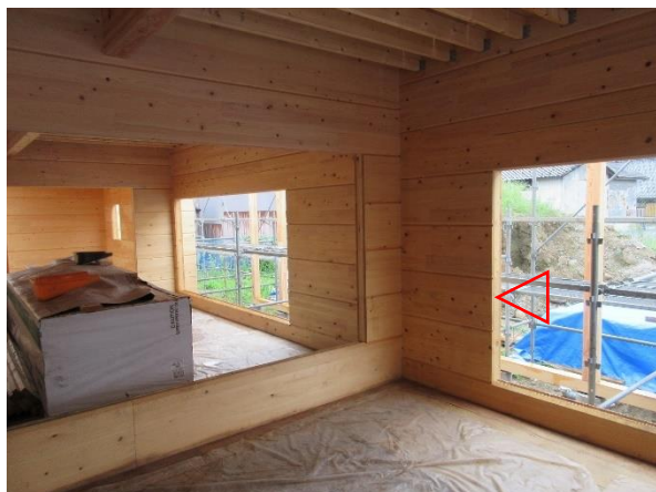
1 階 X4~7×Y6~7 通 壁: JAS 構造材 CLT t120 桧、梁: JAS 構造用集成材 米松
