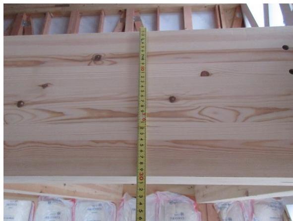
1 階 Y3~4 通 床梁 (燃えしろ構造材) JAS 構造用集成材 せい 300 確認
