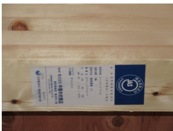
2 階 X1~2×Y1~2 通 中間梁 (燃えしろ構造材) JAS 構造用集成材 JAS シール
