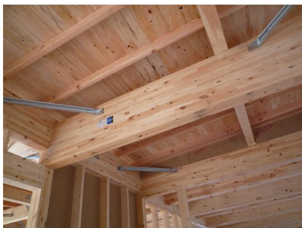
2階 X30 通り Y11 通り付近 集成材梁 RW 集成材 E120-F330 異
