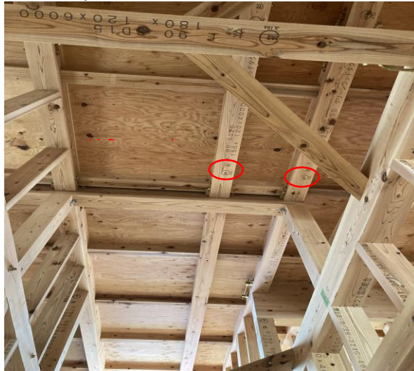
2階 ふ～さ通×12～15通 母屋 JAS 機械等級区分構造用製材
