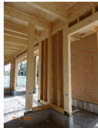
1 階 中央部 屋内階段室付近 内観
