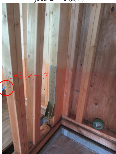
1 階 X8 通×Y7~8 通 たて枠とホールダウン金物
