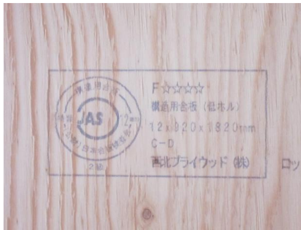
3 階 X19～20 通×Y7～8 通 JAS 構造用合板（屋根）JAS マーク
