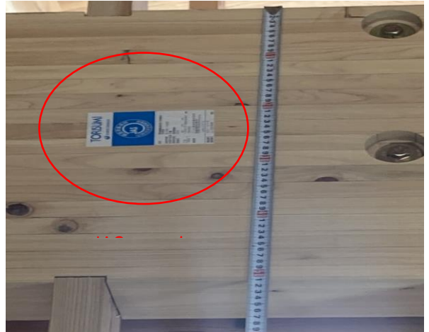
2階 を～よ通×7～10通 桁 JAS 構造用集成材 JAS マーク
