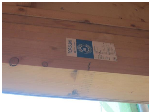
1 階 X8～10 通×Y1a 通 JAS 構造用集成材 JAS マーク
