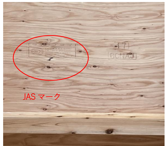
2階 を～よ通×7～10通 野地板 JAS 構造用合板 JAS マーク
