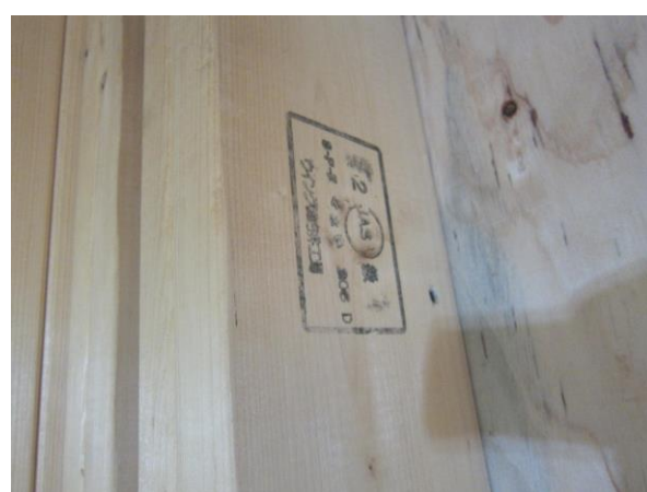
1 階 X1a 通×Y1a~3 通 たて枠 JAS 2×4 製材 JAS マーク
