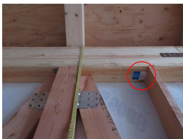
2 階 X1×Y1~5 通 桁: JAS シール・寸法確認 JAS 構造用集成材 120×240
