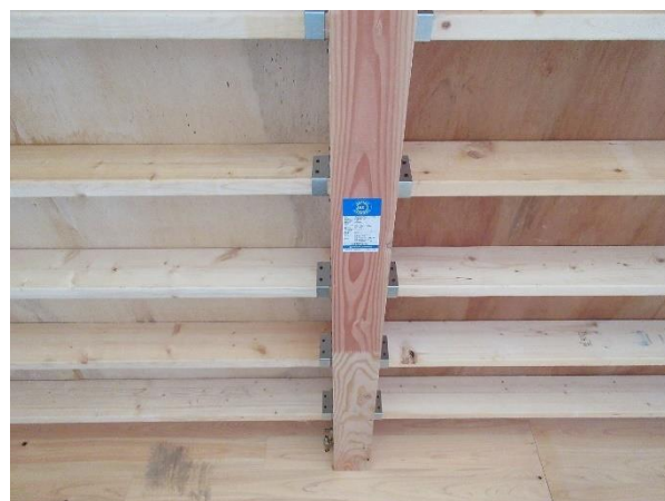
1階 X2~4×Y6~7 通 梁: JAS 構造用集成材 E135-F375 米松 120×210
