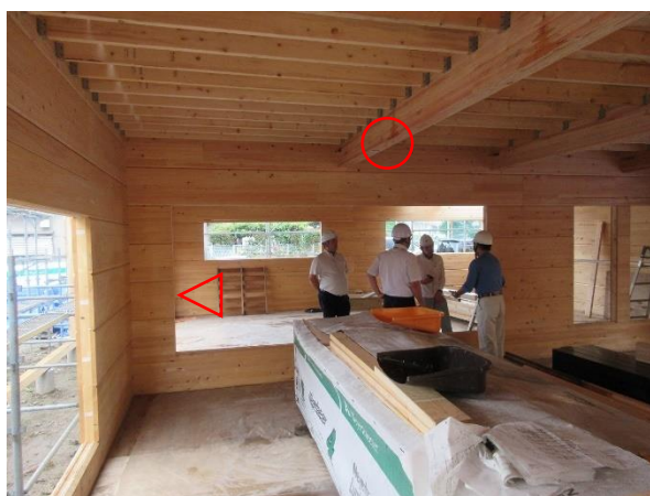
1階 X4~6×Y5~7 通 壁: JAS 構造材 CLT t120 桧、梁: JAS 構造用集成材 米松
