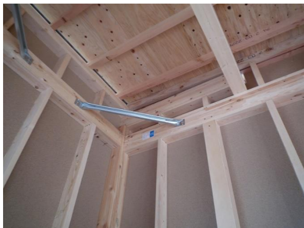
2階 X30 通り Y1 通り付近 集成材梁
