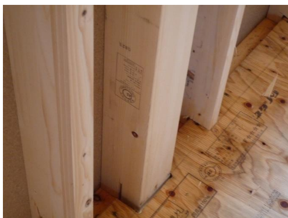
2階 床：構造用合板 t 28 柱：構造用集成材
