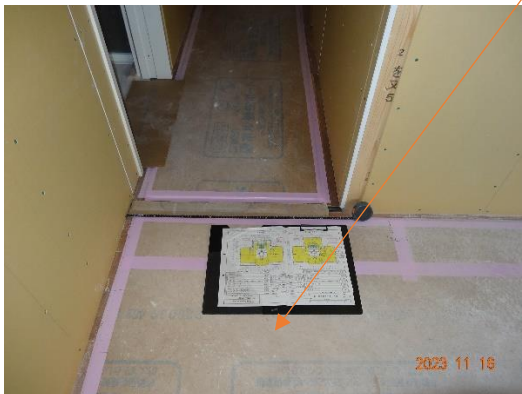
内装材 LDK (廊下) 床仕上材の施工 寸法の確認 壁内法寸法: 巾 5355 (5320)
