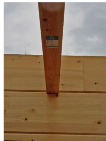
1階 X5~7×Y3~5 通 (中間) 梁: JAS 構造用集成材 米松 120×420
