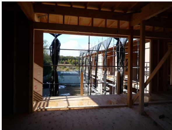
2階 テナント10からテナント6方向 柱・梁：構造用集成材 床：構造用合板 t 28
