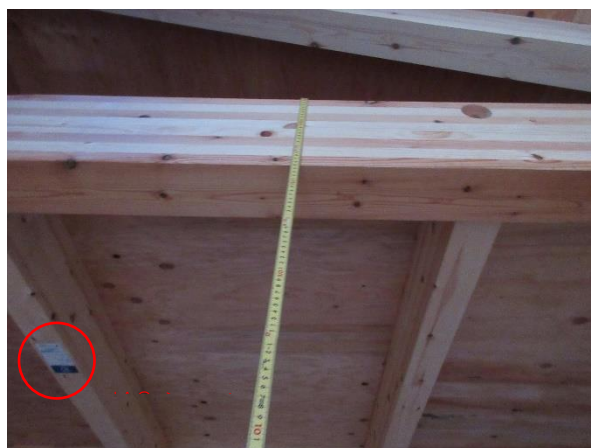
2 階 X1~2×Y2 通 中間梁 (燃えしろ構造材) JAS 構造用集成材 120×240
