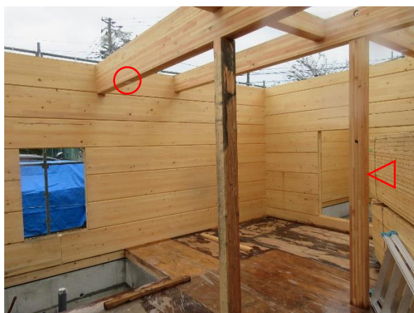
1階 X5~7×Y3~5 通 柱・梁: JAS 構造用集成材 米松
