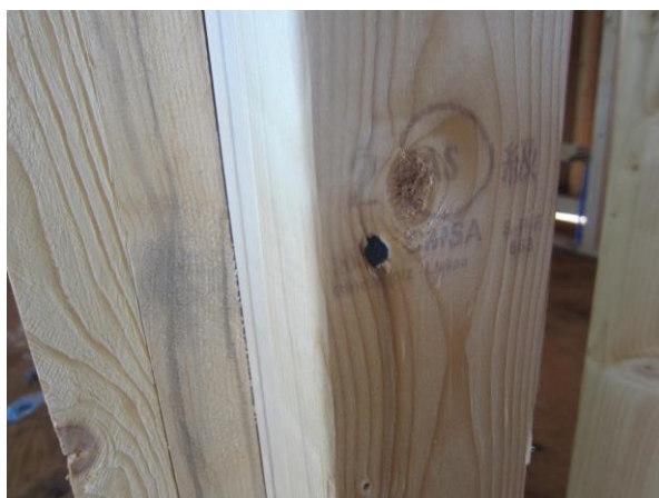
2 階 X14 通×Y5 通 たて枠 JAS 2×4 製材 JAS マーク
