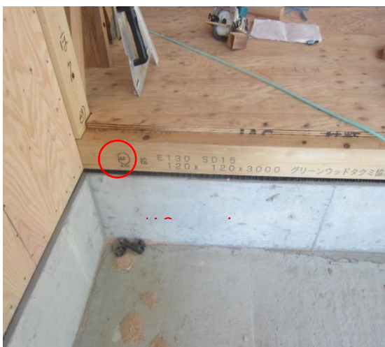
1 階 ほ通×4~7 通 土台 JAS 機械等級区分構造用製材
