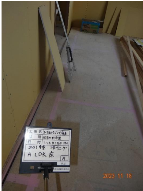
内装材 LDK (リビング) 床仕上材の施工 寸法の確認 壁内法寸法: 巾 5355 (5320)
