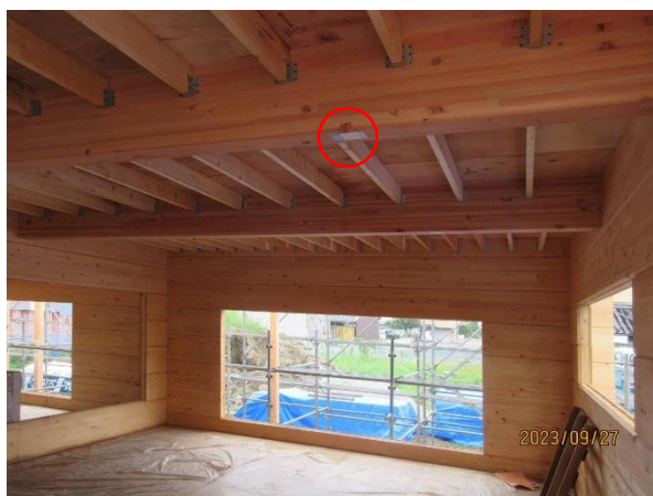
1 階 X5~7×Y6~7 通 壁: JAS 構造材 CLT t120 桧、梁: JAS 構造用集成材 米松
