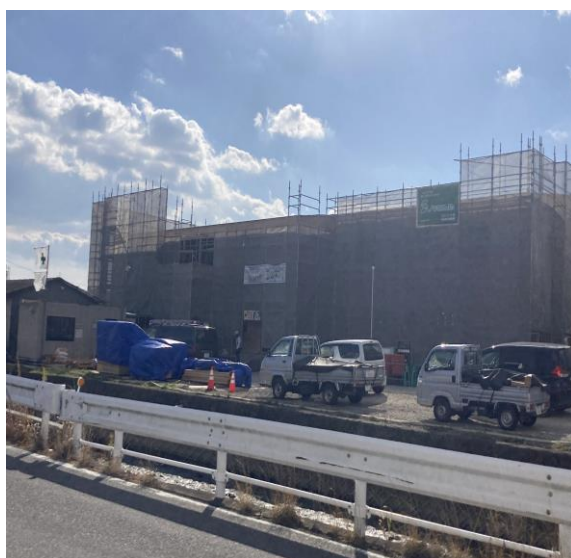
建物外観（北側道路より撮影）
