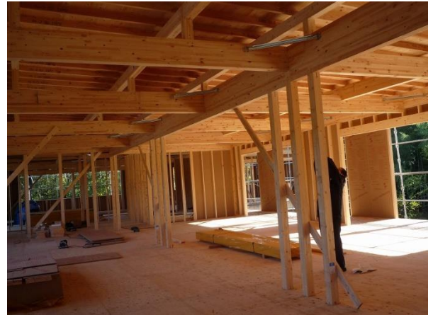
2階 テナント8からテナント9方向 柱・梁：構造用集成材 床：構造用合板 t 28
