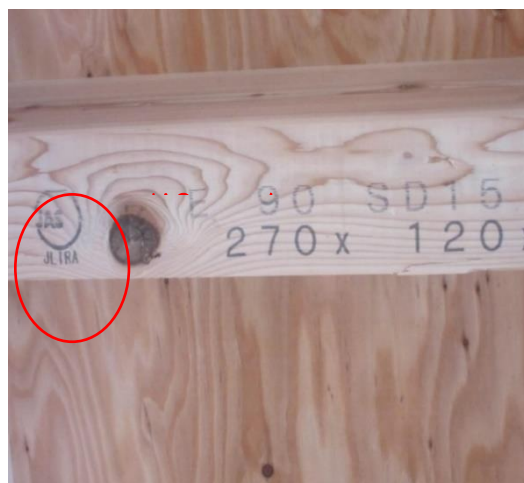
1階 梁 JAS 機械等級区分構造用製材 JAS マーク
