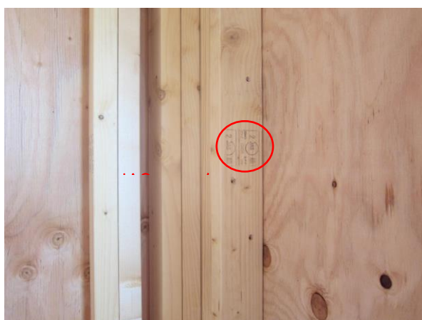
3階 X20～21 通×Y1a～Y3 通 たて枠 JAS 2×4 製材
