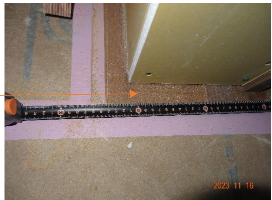
内装材 LDK (洗面) 床仕上材の施工
