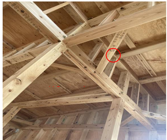
2階 つ通×1 通 柱 JAS 機械等級区分構造用製材 JAS マーク
