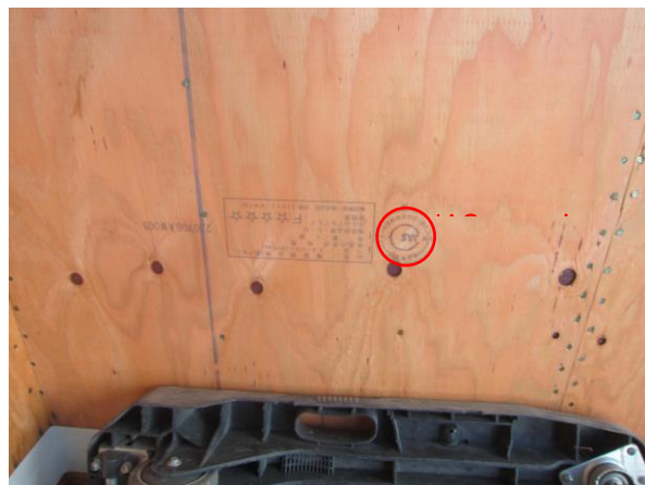
1 階 X10 通×Y1a～3 通 JAS 構造用合板（壁） JAS マーク
