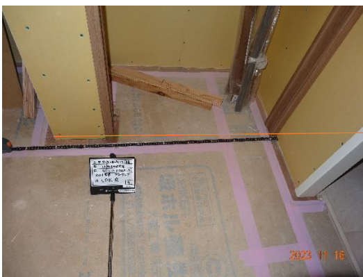
内装材 LDK (収納) 床仕上材の施工
