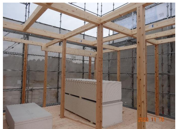
2階 柱、梁取り合い
