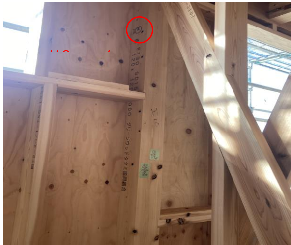
2階 つ通×1 通 柱 JAS 機械等級区分構造用製材
