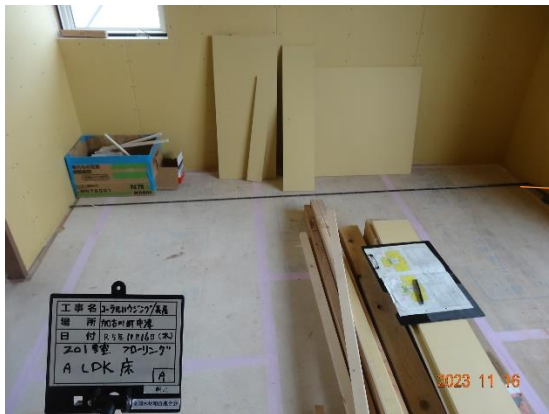
内装材 LDK 床仕上材の施工寸法の確認 壁内法寸法：巾 3080 (3050)
