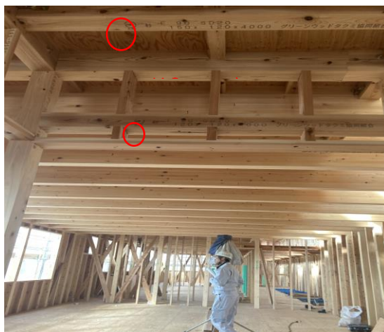
2階 つ通×1 通 柱 JAS 機械等級区分構造用製材
