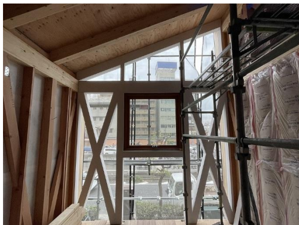
2 階 道路側 Y5 通 架構部材：耐火被覆仕様へと変更
