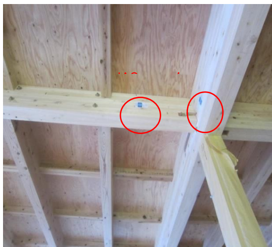
1階 梁・桁 JAS 構造用集成材
