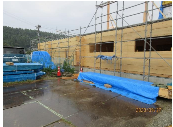
外観（東面） CLT 版 H400×7 段
