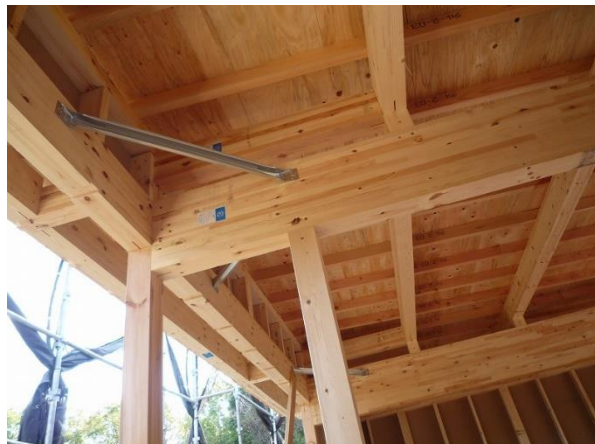
2階 X37 通り Y7 通り付近 集成材梁 RW 集成材 E105-F300 異
