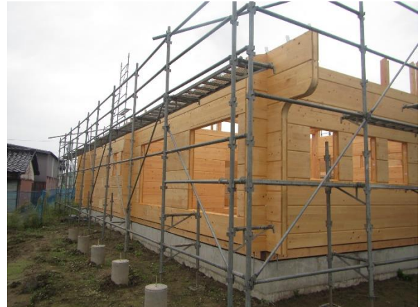
外観（西面） デッキ出入口 開口 ▽：寸法計測 確認
