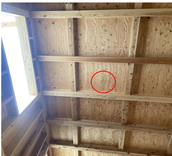
2階 を～よ通×7～10通 野地板 JAS 構造用合板
