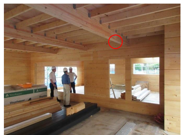
1階 X5~6×Y5~7 通 壁: JAS 構造材 CLT t120 桧、梁: JAS 構造用集成材 米松
