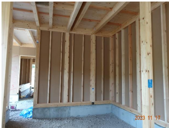
1 階 中央部 屋内階段室付近 内観
