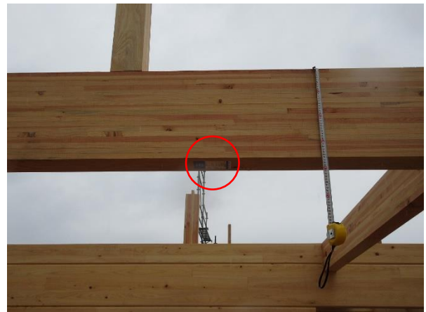
1階 X1~3×Y2~3 通 梁: JAS 構造用集成材 E135-F375 米松 120×360
