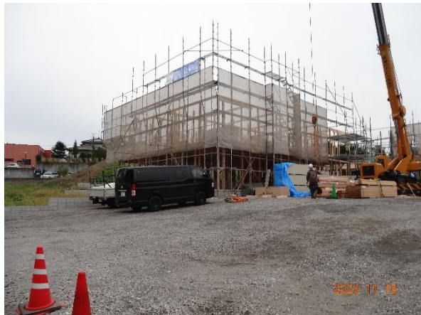
建物外観 建て方未了
