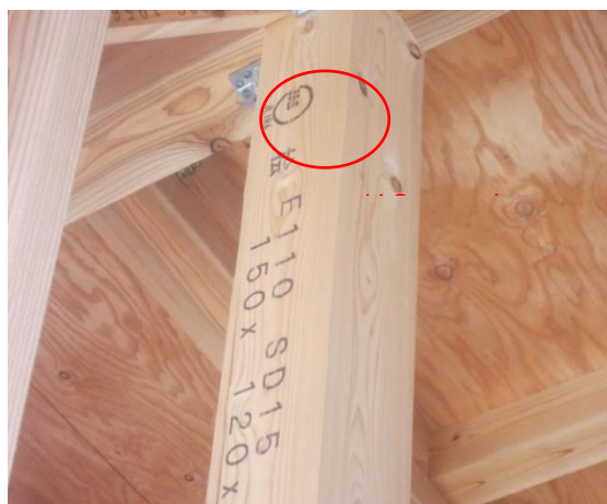
1 階 柱 JAS 機械等級区分構造用製材 JAS マーク
