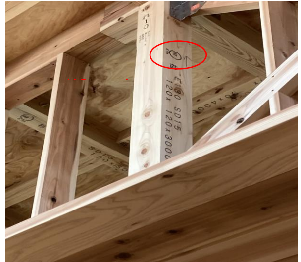
2階 れ通×10通 小屋束 JAS 機械等級区分構造用製材
