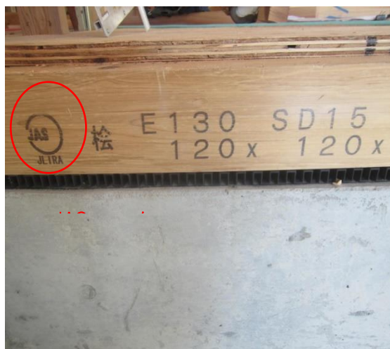
1 階 ほ通×4~7 通 土台 JAS 機械等級区分構造用製材 JAS マーク
