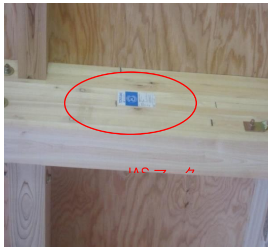
1階 梁・桁 JAS 構造用集成材 JAS マーク
