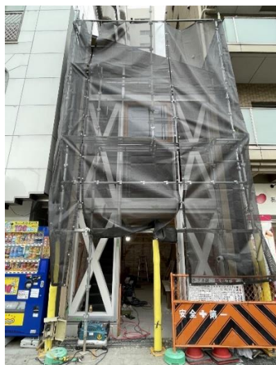
建物外観 正面（ガラス張） 前面の架構：被覆仕様に変更
