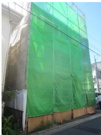
建物外観（北側道路より撮影）
