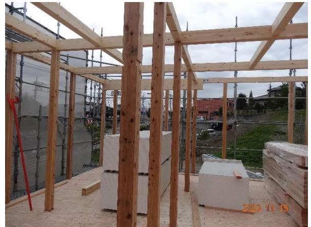
柱 JAS 構造用集成材から無等級製材に変更
