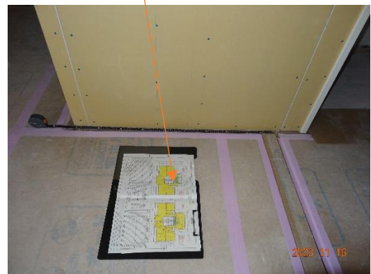
内装材 LDK (洗面側) 床仕上材の施工 寸法の確認 壁内法寸法: 巾 910 (910)
