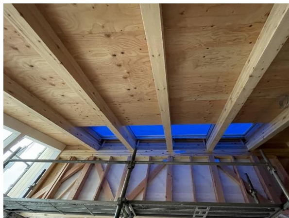
2 階 屋根 X1~2×Y1~5 通 登り梁、(燃えしろ構造材) JAS 構造用集成材 120×180
