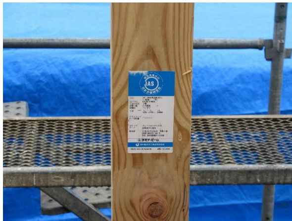
1階 X6~7×Y8 通 柱: JAS 構造用集成材 E135-F405 米松 120 角
