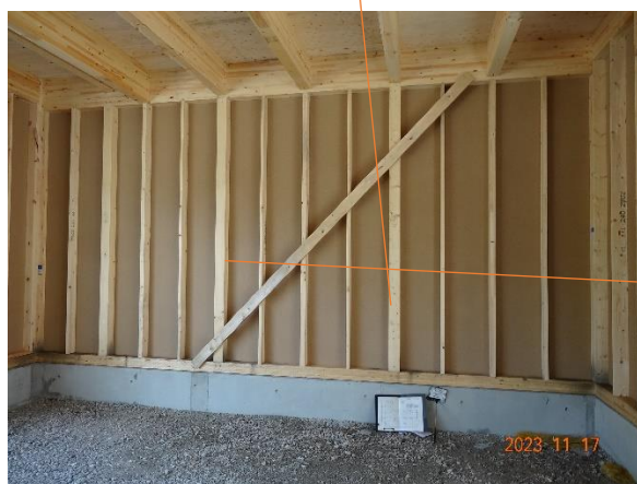
1階 Y1 通り-X30-37 間 通し柱：管柱
