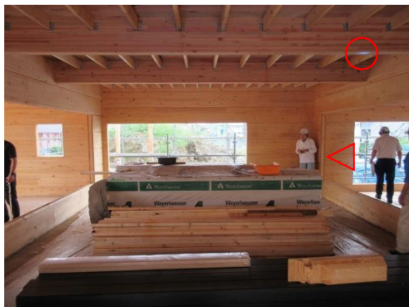
1階 X4~6×Y5~7 通 壁: JAS 構造材 CLT t120 桧、梁: JAS 構造用集成材 米松
