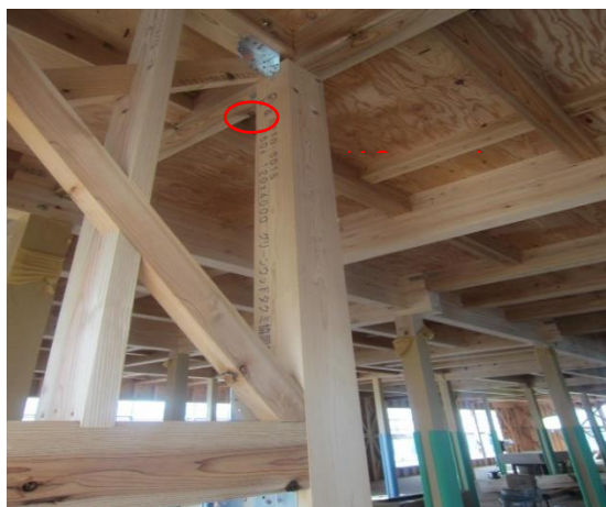
1 階 柱 JAS 機械等級区分構造用製材
