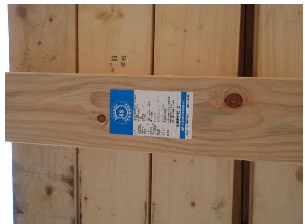
1階 X1~3×Y4~5 通 梁: JAS 構造用集成材 E135-F375 米松 120×270
