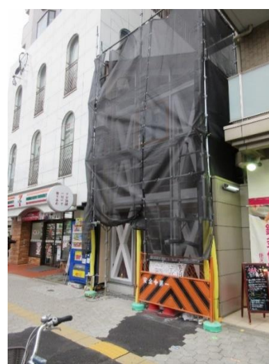
建物外観 側面（屋根・外壁） 被覆完了を確認
