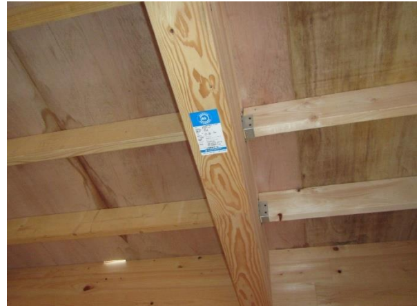
1階 X4~6×Y6 通 梁: JAS 構造用集成材 E135-F375 米松 120×360
