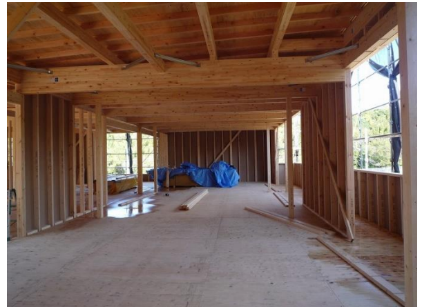
2階 テナント10からテナント9方向 柱・梁：構造用集成材 床：構造用合板 t 28
