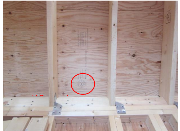
3 階 X19～20 通×Y7～8 通 JAS 構造用合板（屋根）JAS マーク
