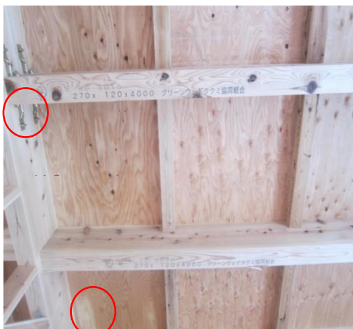
1階 梁 JAS 機械等級区分構造用製材
