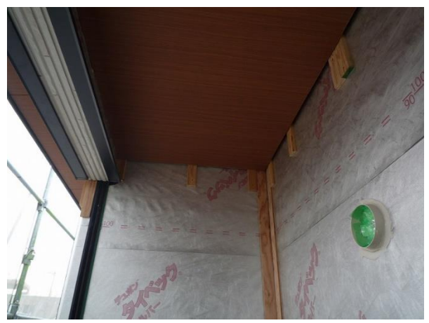
木質耐火 外壁 EXハイパー t 9.5 ハイベストウッド t 9 通気胴縁 t 15
