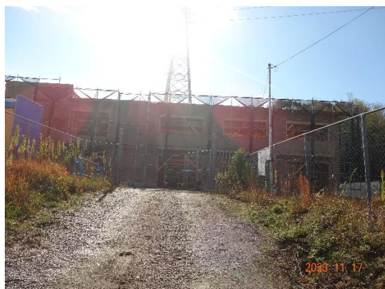
外観 2階建て事務所 前面道路側より見る
