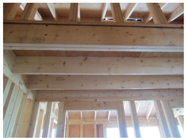
3 階 X16～X18 通×Y5～Y7 根太 JAS 2×4 製材
