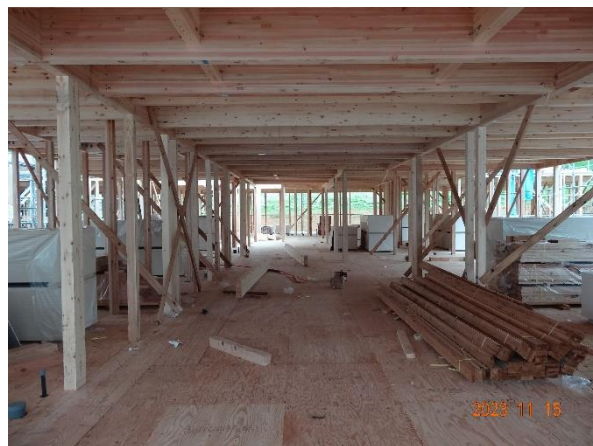
2 階床 一部機械等級製材からすべて構造用集成材に変更されている
