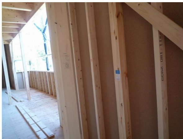
2階 X37通り Y13通り付近 集成材柱
