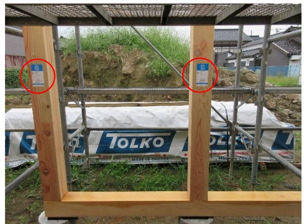
1階 X4~5×Y8 通 柱: JAS 構造用集成材 E135-F405 米松 120 角
