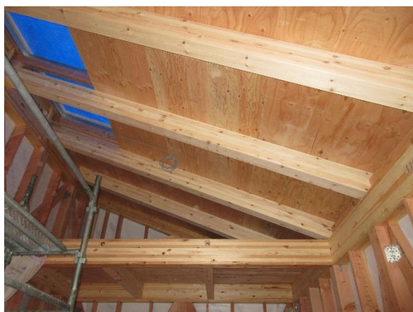
2 階 X1~2×Y1~3 通 中間梁 (燃えしろ構造材) JAS 構造用集成材 120×240、210
