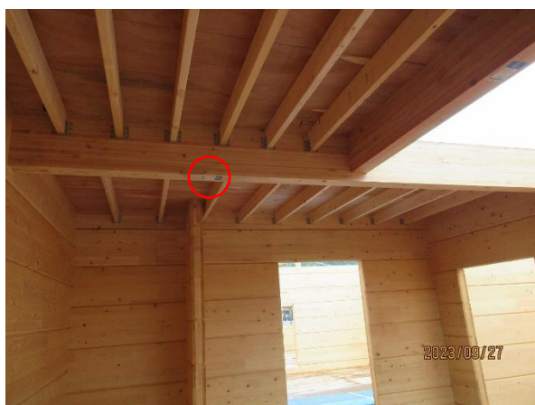
1階 X2~4×Y5~7 通 壁: JAS 構造材 CLT t120 桧、梁: JAS 構造用集成材 米松
