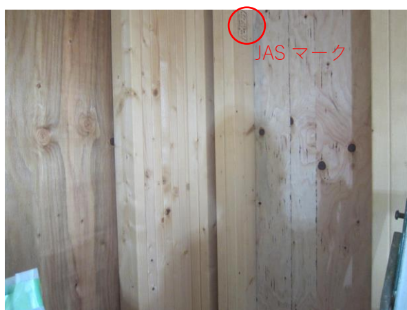
1 階 X1a 通×Y1a~3 通 たて枠 JAS 2×4 製材
