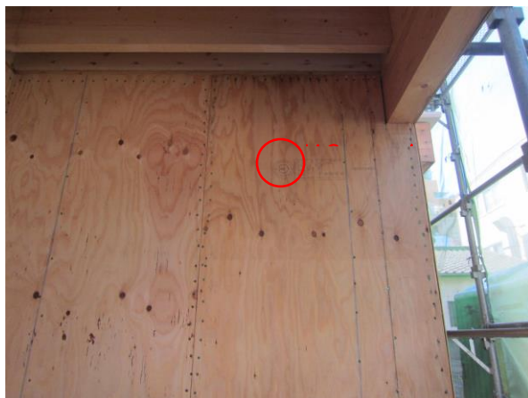
1 階 X10 通×Y1a～3 通 JAS 構造用合板（壁）
