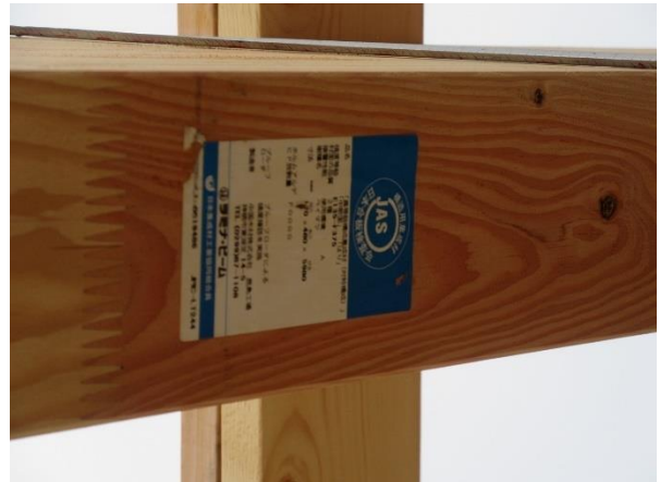
1 階 X3~5×Y3 通 梁: JAS 構造用集成材 E135-F375 米松 120×480
