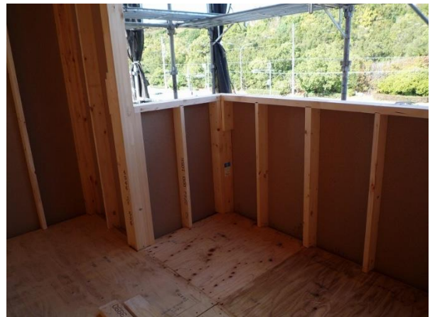
2 階 テナント 6 室外機置場 Y26 通り付近 柱・地束：構造用集成材 床：構造用合板 t 28
