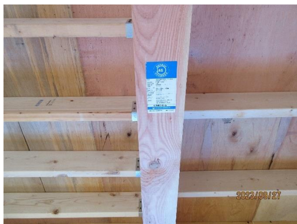
1 階 X6~7×Y6~7 通 梁: JAS 構造用集成材 E135-F375 米松 120×360
