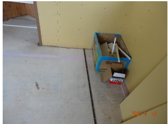
内装材 LDK 床仕上材の施工寸法の確認 壁内法寸法：巾 5355 (5320)
