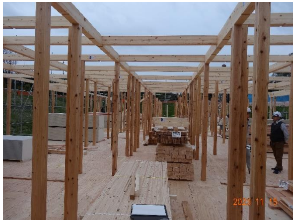
2階内観 建て方中
