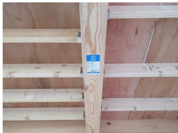
1階 X2~4×Y6 通 梁: JAS 構造用集成材 E135-F375 米松 120×330
