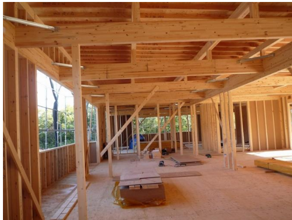
2階 テナント6からテナント9方向 柱・梁：構造用集成材 床：構造用合板 t 28
