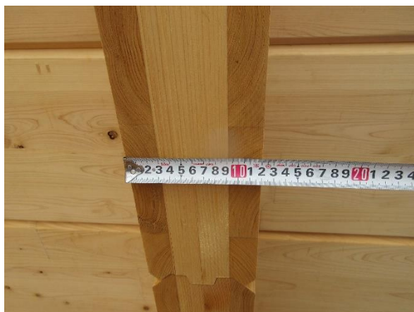
1 階 X5×Y3 通 壁: JAS 構造材 CLT 3 層 4 プライ T120 桧
