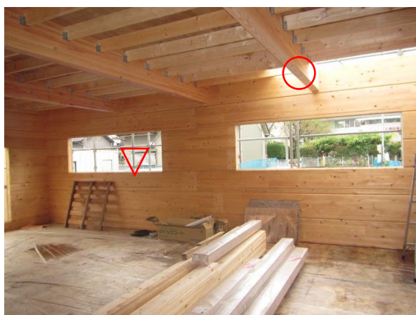
1 階 X6~7×Y5~7 通 壁: JAS 構造材 CLT t120 桧、梁: JAS 構造用集成材 米松
