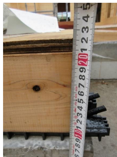
1階 X3~5×Y3~2 通 床: JAS 構造用合板 土台は助成対象外
