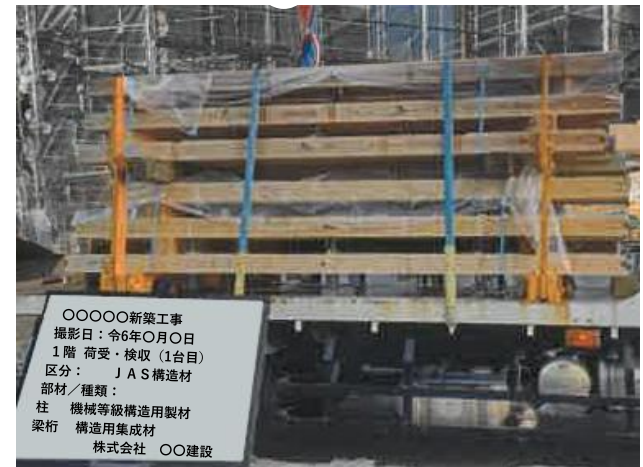
荷受け検収写真の例
