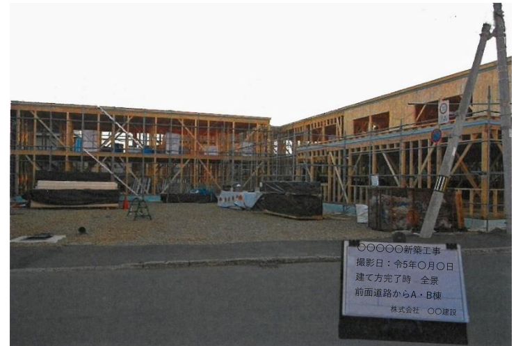
写真 外観写真の例
