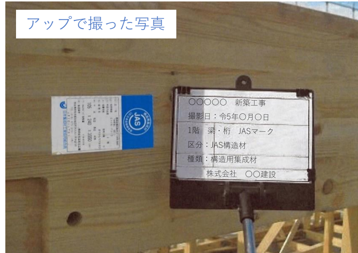
写真 施工写真の例
